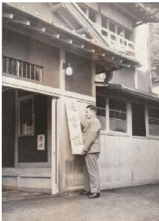
改修なった凌雲荘に真新しい看板設置
